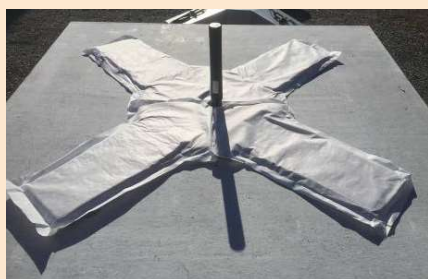
ざぶとん材敷設状況
