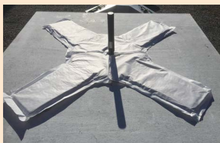
ざぶとん材敷設状況
